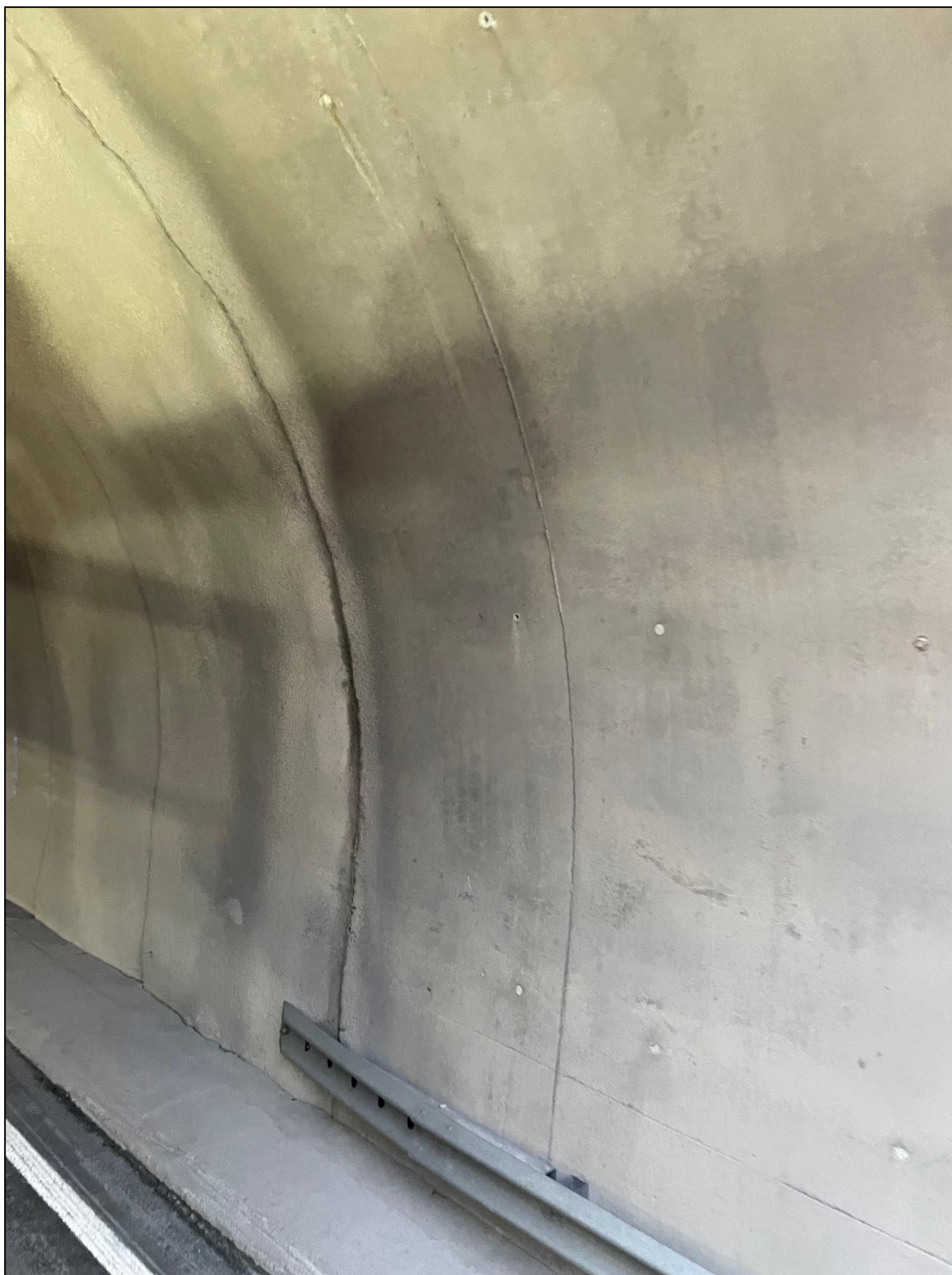
Foto 7. Brannsikret PE-skum gjennom hele tunnelens lengde. I overgang tunnelportal til vann- og frostsikring, er det registrert sprekk.
