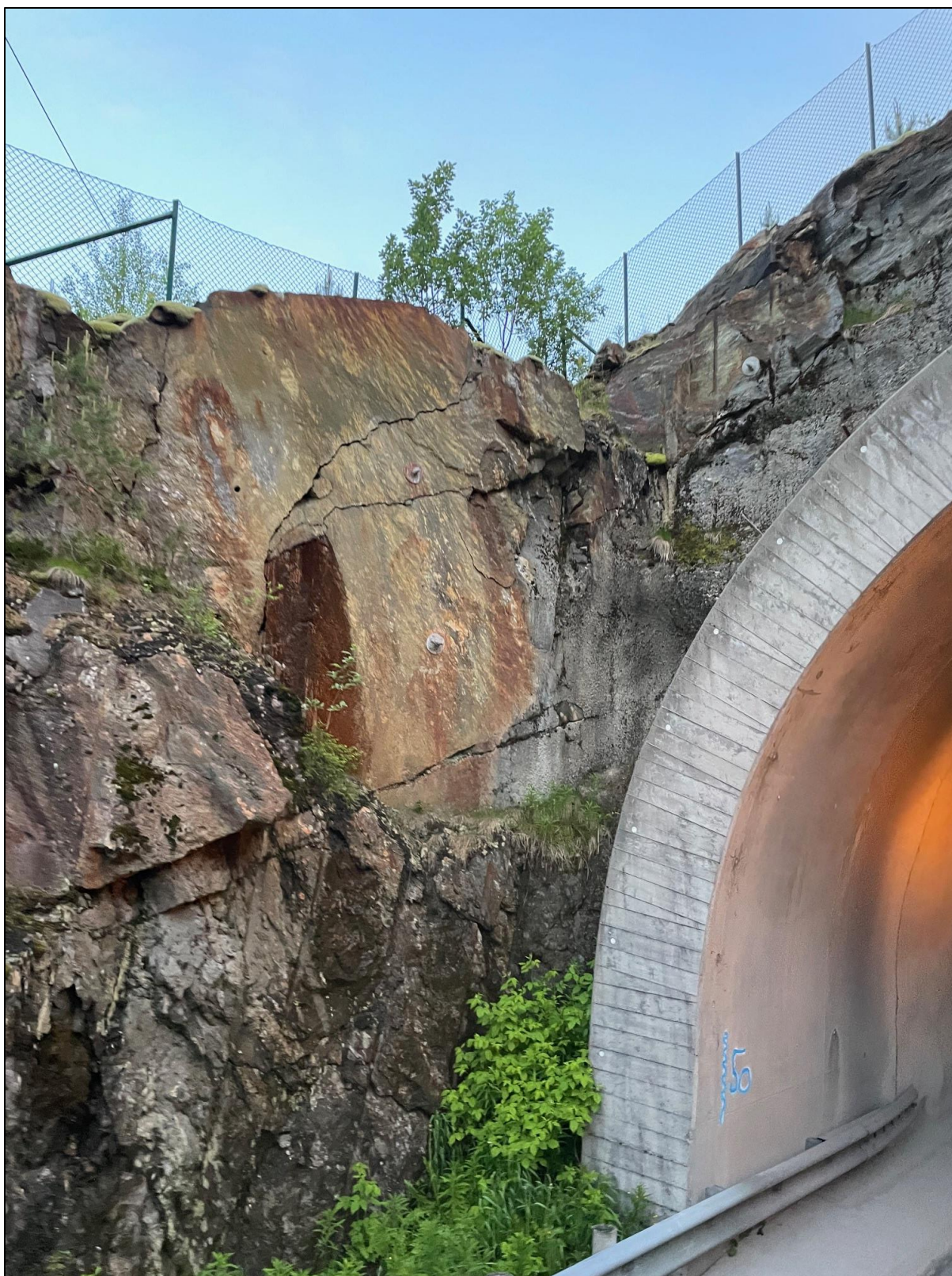
Foto 6. Forskjæring i øst. Sikret med et par spredte bolter, og sprøytebetong i påhuggsflaten.
