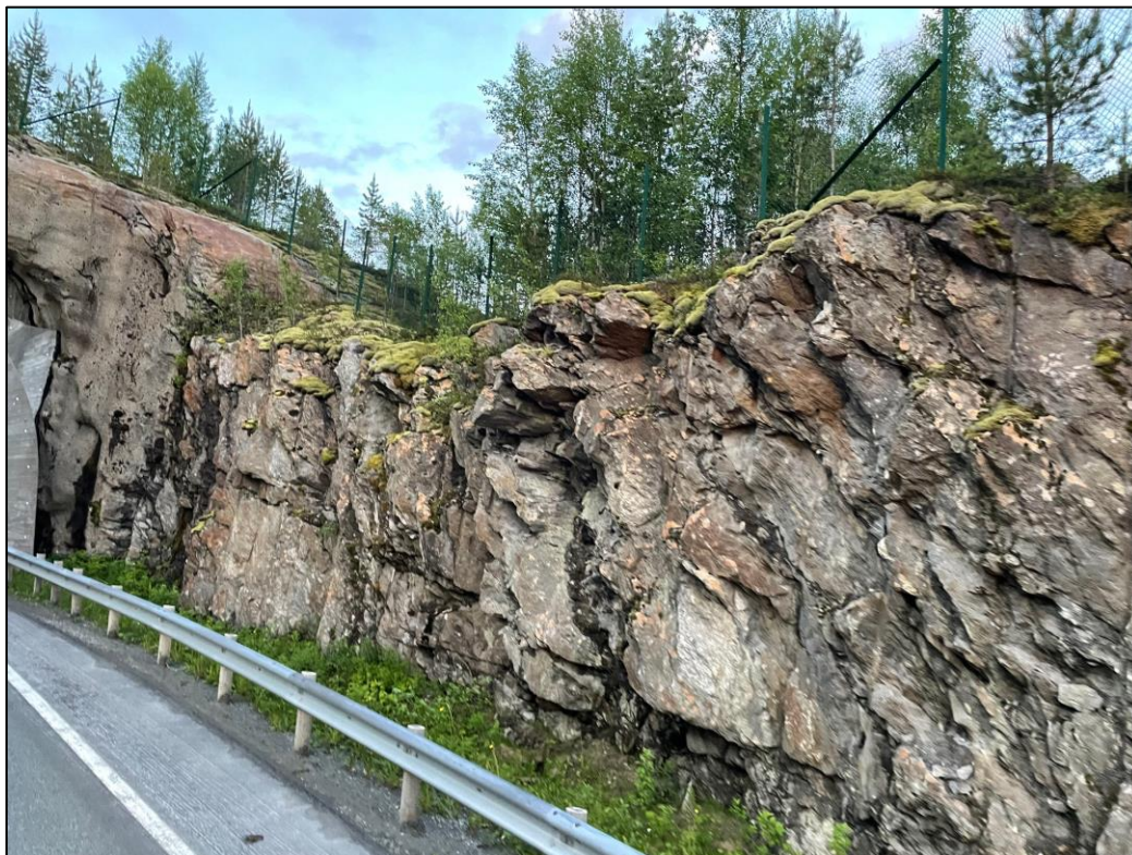
Foto 3. Oversikt forskjæring i vest, høyre side. Lav skjæring med tilstrekkelig grøftebredde.
