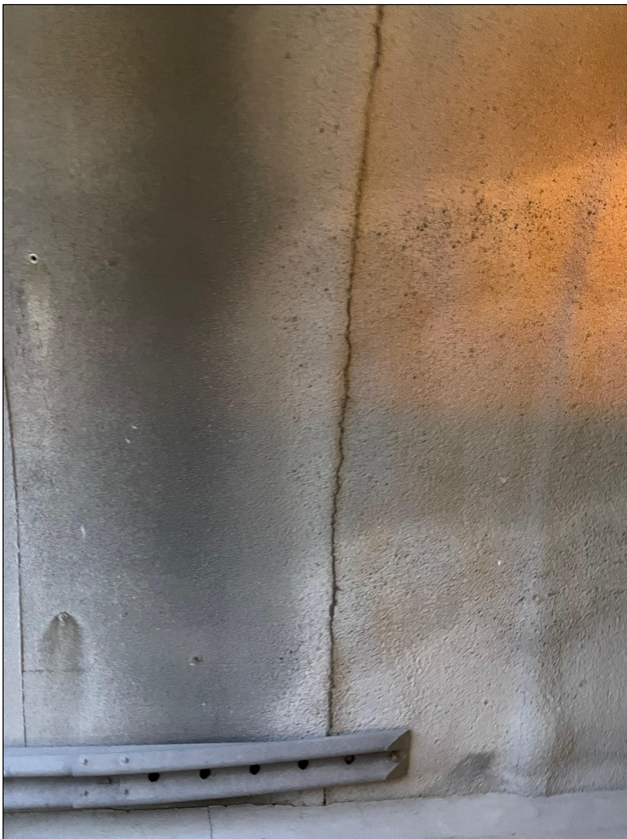
Foto 9. Fuget sprekk i PE-skum.
