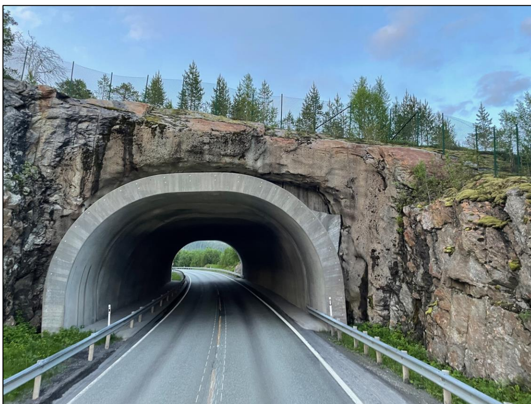
Foto 2. Oversikt forskjæring vest. Sprøytebetongsikret påhuggsflate.
